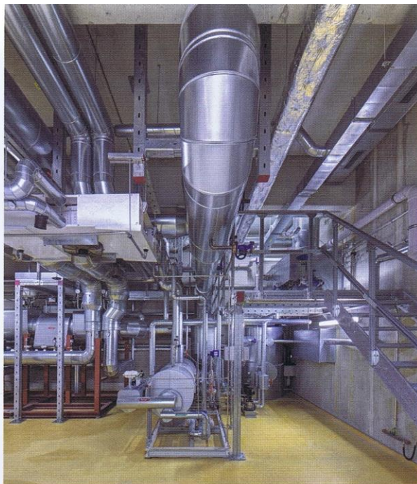
Das Biomasseheizkraftwerk der Naturenergie Cham liefert der Käserei Prozesswärme aus regenerativen Hackschnitzeln. Links: Gammel Engineering legte eine optimierte Medientrasse zwischen Betrieb und Kraftwerk.
