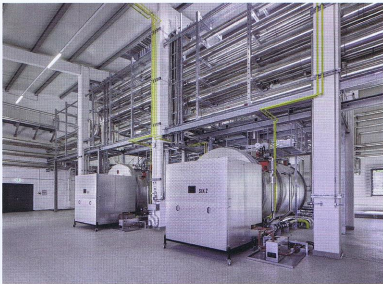
Eine hocheffektive Gasturbine, die mit Bio-Erdgas betrieben werden kann und H 2 -ready ist, versorgt die Molkerei in Piding mit Dampf, Wärme und Strom. Rechts: Zwei Satteldampfkessel mit Zweistoffbrennern (Öl/Gas) decken den Spitzenlast-Dampfbedarf ab.
