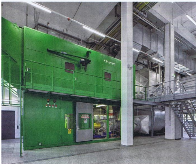
Eine hocheffektive Gasturbine, die mit Bio-Erdgas betrieben werden kann und H 2 -ready ist, versorgt die Molkerei in Piding mit Dampf, Wärme und Strom. Rechts: Zwei Satteldampfkessel mit Zweistoffbrennern (Öl/Gas) decken den Spitzenlast-Dampfbedarf ab.
