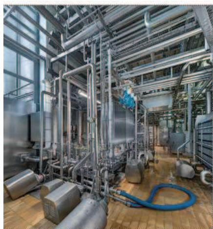
Nach Installation aller neuen Komponenten erfolgte eine abschließende Verbindung zwischen den bestehenden Prozessdampfinstallationen und den BHKW-relevanten Komponenten zu einem Gesamtsystem, sodass auch Prozesse wie die Wasseraufbereitung oder Entgasung in das neue Energienetz eingebunden sind.
