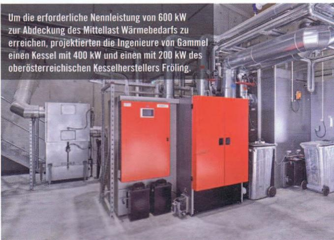
Um die erforderliche Nennleistung von 600 kW zur Abdeckung des Mittellast Wärmebedarfs zu erreichen, projektierten die Ingenieure von Gammel einen Kessel mit 400 kW und einen mit 200 kW des oberösterreichischen Kesselherstellers Fröling.
