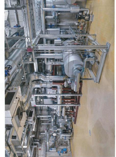
Ein Reindampferzeuger mit einer Leistung von 500 kg/h wandelt den Dampf in Reindampf für Prozesse um; ein Heizkondensator generiert 95 °C heißes Wasser zum Heizen. Fotos: Gammel Engineering GmbH
