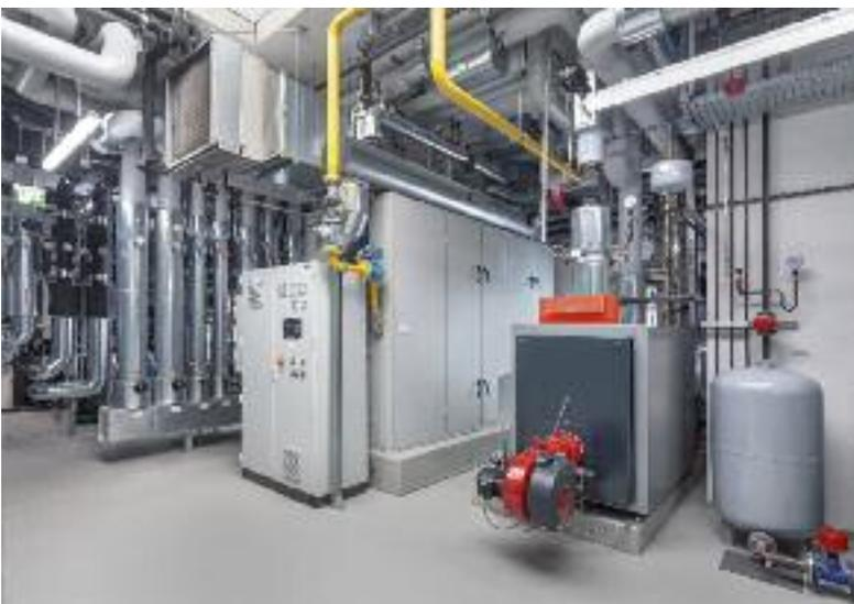
◀ Bild 7 • Ein Blockheizkraftwerk mit einer Leistung von 125 kWel und 184 kWth arbeitet nach dem Prinzip der Kraft-Wärme-Kopplung und stellt die benötigte Energie für verschiedene Prozesse im Unternehmen bereit.
