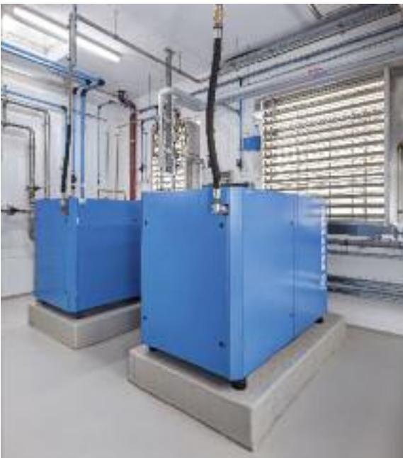
▲ Bild 11 • In der Druckluftzentrale wird die Abwärme der Kompressoren optimal zur Klimatisierung des neuen Produktions- und Verwaltungsgebäudes genutzt.
