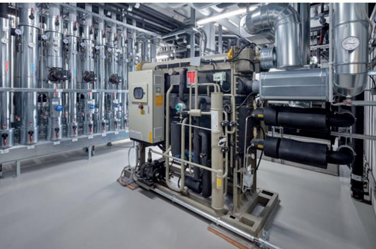
Um den Betrieb mit der erforderlichen Kälte zu versorgen, wurde eine Absorptionskältemaschine installiert. Außerdem verfügt die Kältezentrale über mehrere Pufferspeicher, sodass der Energieverbrauch zur Erzeugung der benötigten Temperatur sehr niedrig gehalten werden kann.
