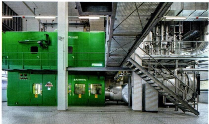
**Bild 1:** Um einen Großteil des hohen Jahresdampfbedarfs selbst zu decken, wurden eine Gasturbine, ein Abhitzedampfkessel sowie zwei Spitzenlastkessel installiert. (Quelle: Gammel Engineering)
