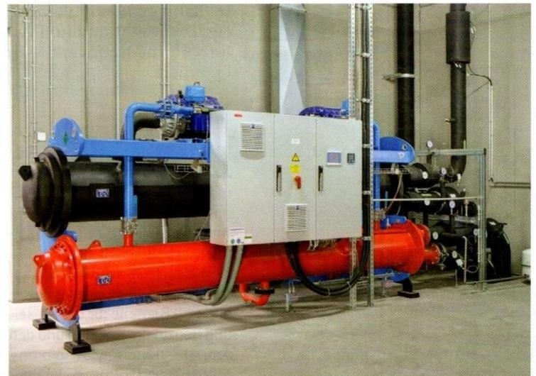
Der Kältekompressor erreicht COP-Zahlen bis zu 6. Die Kältezentrale wurde so geplant, dass bei kalten Außentemperaturen eine freie Kühlung möglich ist.
