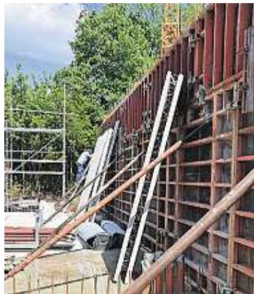
**Die Außenwände werden mittels Betonschalungen hergestellt, die dann gegossen werden.**
