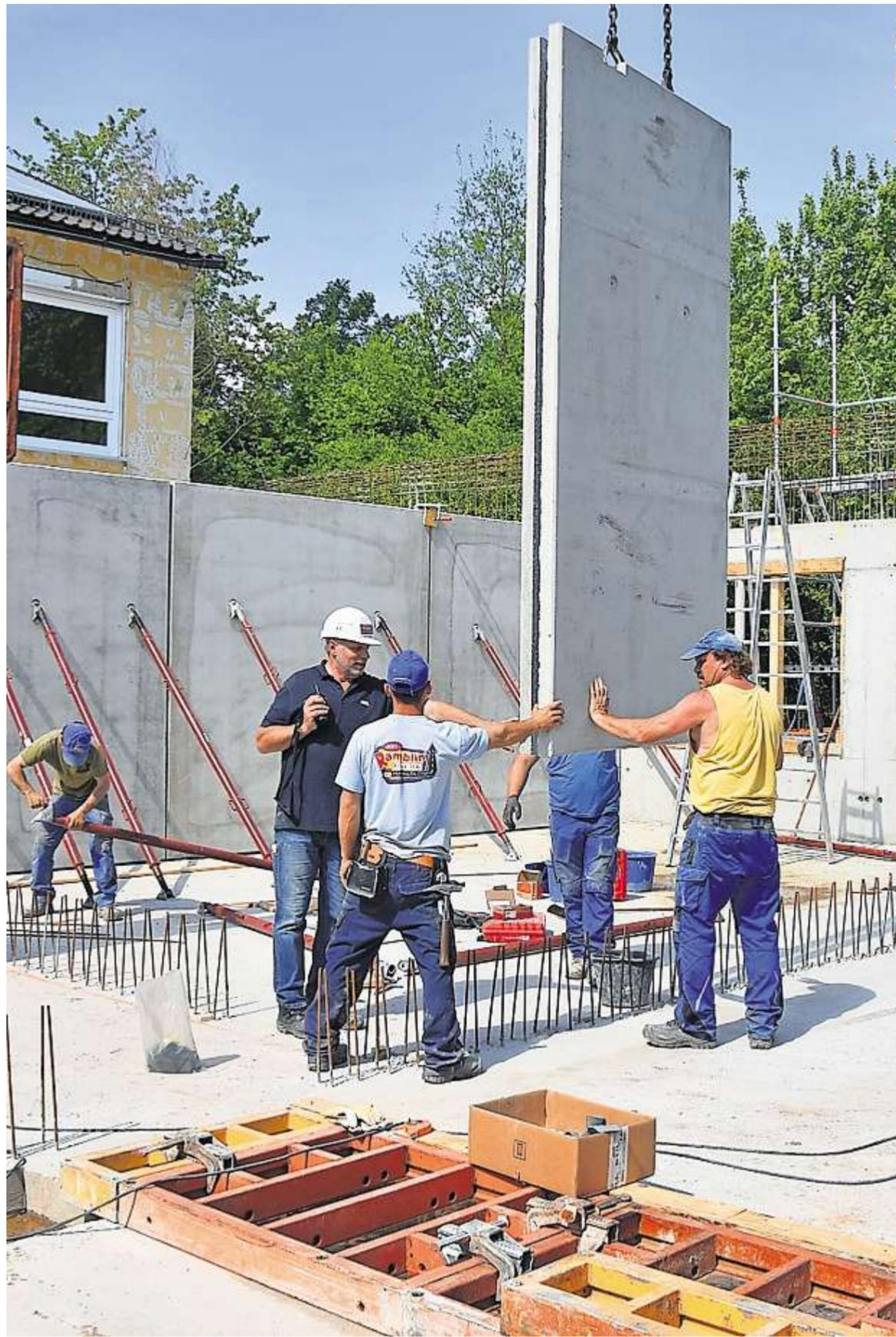
**Die Fertigbetonteile werden passgenau geliefert und mit einem Kran – und trotzdem viel Handarbeit – in Stellung und ins Wasser gebracht und dann ausgegossen.**
