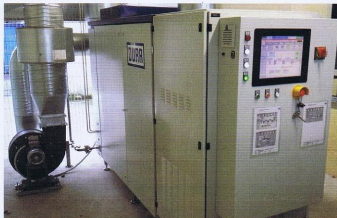
■ **Abb. 3:** Die neue Turbine erzeugt neben 100 kW Strom auch Abgase. Diese durchströmen einen speziellen Vierzugkessel und produzieren so 0,5 t/h Satt-dampf, der die Grundlast im Betrieb abdeckt. Bei einem höheren Bedarf kann zusätzlich ein stufenloser Gasbrenner betrieben werden, sodass im Kombibetrieb bis zu 2,5 t/h Satt-dampf erzeugt werden.
