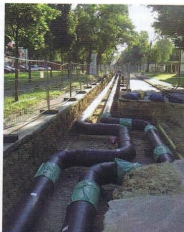
*Die Hauptfernwärmeleitung wurde vom Biomasseheizkraftwerk über Landshut Ost verlegt. Dafür wurden Kunststoffmantelrohre mit PUR-Schaumdämmung bis DN 300 verbaut, die eine technische Lebensdauer von mindestens 30 Jahren besitzen.*
