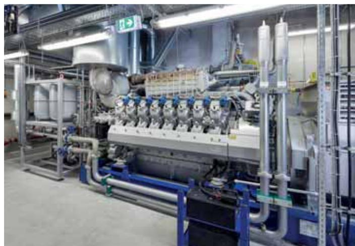
Gammel Engineering entwickelte und plante für das Osram-Werk in Eichstätt ein Blockheizkraftwerks-Modul mit 2.000 kW<sub>el</sub> und 2.000 kW<sub>th</sub> sowie eine Absorptionskältemaschine mit 738 kW. Die Installation erfolgte durch die MTU Onsite Energy GmbH. Die Anlage wurde vom B.KWK zum BHKW des Jahres gekürt.
