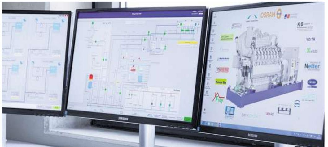
Die Bedienzentrale mit den Anlagenschaubildern und den Onlinedaten des Heizkraftwerkes. Die Anlage fährt selbstüberwacht ohne ständige Beaufsichtigung. Sämtliche Betriebsdaten werden in der Leittechnik erfasst, aufgezeichnet und für die Betriebsoptimierung ausgewertet.
