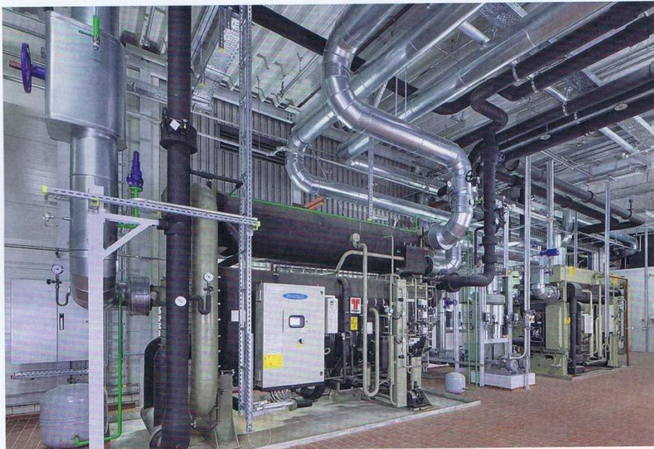
In der Energiezentrale von BMW Landshut wurden zwei Absorptionskältemaschinen errichtet, die sich aus dem zentralen Wassernetz speisen und die Abwärme aus den Schmelzöfen nutzen, um Kälte zu erzeugen
