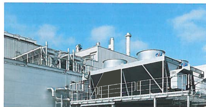
Moderne hybride Trockenkühler ergänzen das Energiekonzept im BMW-Group-Werk Landshut.
