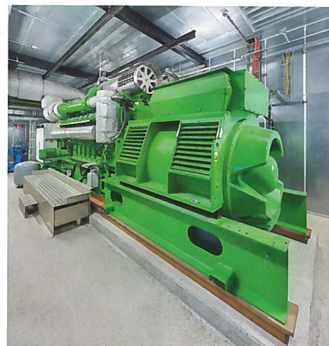
Ein zusätzliches Blockheizkraftwerk mit einer Leistung von 2,4 MW th und 2,6 MW el komplettiert das neue Energiekonzept, so dass durch die neuen Anlagen die Grundlast praktisch vollständig abgedeckt werden kann.
