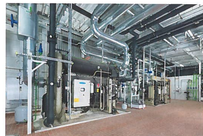
In der Energiezentrale des BMW-Group-Werks Landshut wurden zwei Absorptionskältemaschinen errichtet, die sich aus dem zentralen Wassernetz speisen und die Abwärme aus den Schmelzöfen nutzen, um Kälte zu erzeugen.
