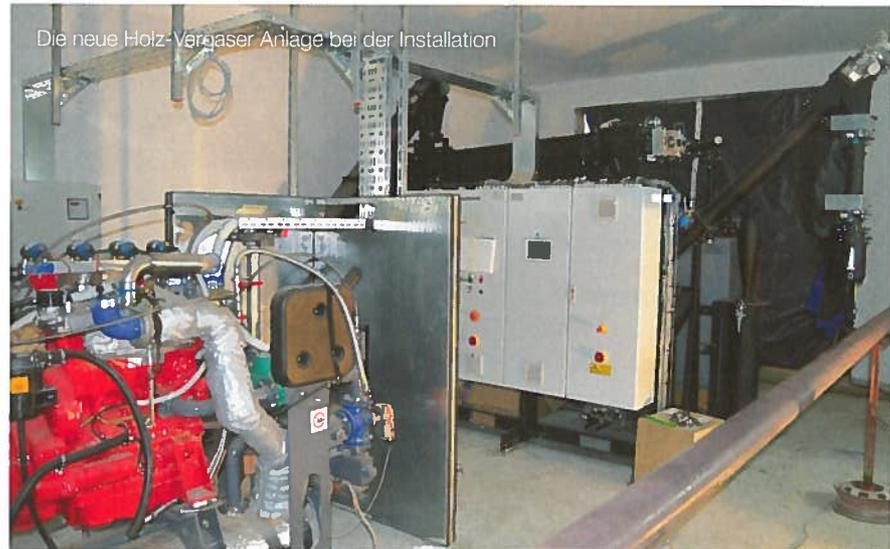
gerade recht: Die Grundlast des Strom- und Wärmebedarfs übernimmt zukünftig ein Blockheizkraftwerk des österreichischen Herstellers Fröling.
