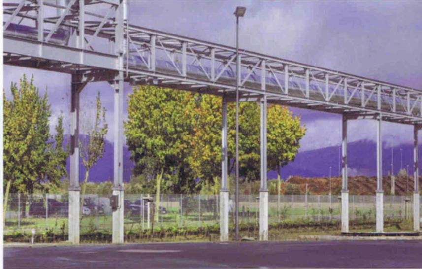
Der überschüssige Dampf aus der nahegelegenen Papierfabrik wird abgezweigt und per unter- und oberirdischen Leitungen transportiert. Über eine Rohrbrücke gelangt der Dampf zum Technikhaus der Molkerei.
