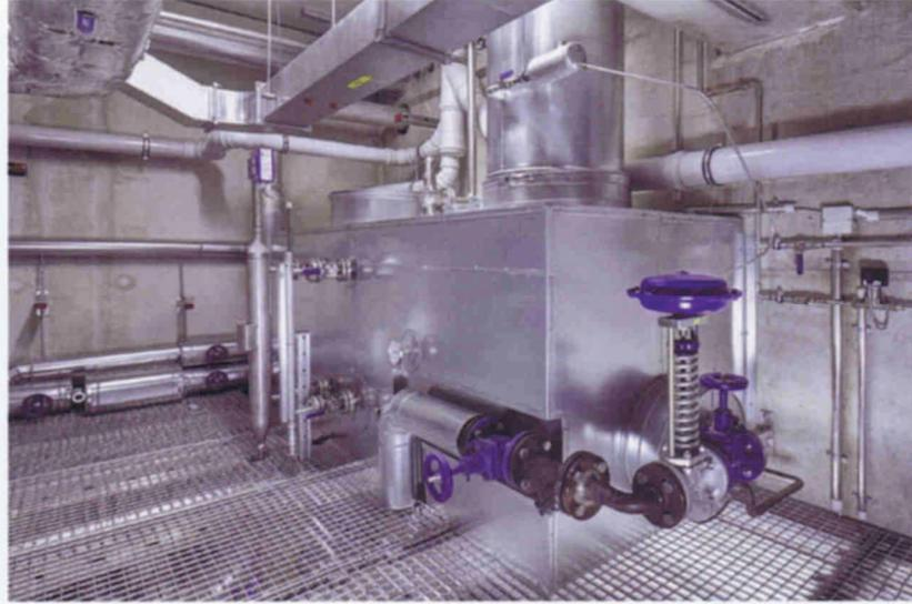
Im Technikgebäude wird der Dampf in Reindampf und 95 Grad Celsius heißes Wasser zum Heizen umgewandelt. Ein Wärmeübertrager mit einer großen Tauscherfläche sorgt für einen Wärmeübergang fast ohne Druckverlust.
