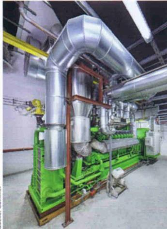
Um ausreichend Energie für die Heizung der Büroräume zu erhalten, nutzt Gammel die Abwärme des erdgasbetriebenen BHKWs auf dem benachbarten Hauptwerkgelände. Durch die Nutzung der Abwärme steigert sich auch die Energieeffizienz des bestehenden BHKWs nochmals.
