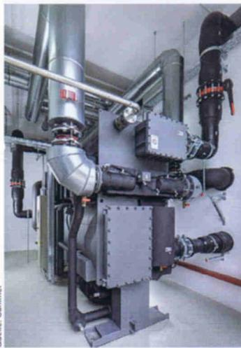
Im bestehenden Werk gibt es eine Kraft-Wärme-Kälte-Kopplung mit einer Absorptionskältemaschine. Über eine Erdleitung wird die Niedertemperatur-Abwärme des Gemischkühlers, die ansonsten keine Verwendung findet, in das Heizungsnetz eingespeist.
