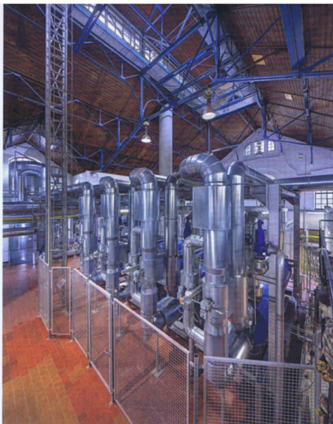
Abb. 4: Für die Grundversorgung während der Umbauarbeiten wurde auf dem Gelände eine mobile Heizstation installiert
